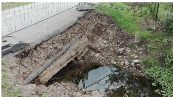
Im Rahmen der Schadensbeseitigung Hochwasser 06/2013 erfolgte der Ersatzneubau des Durchlasses „Alte Straße“. Der ehemalige Durchlass wies vor allem in den Gründungsbereichen starke Schäden auf. Weiterhin zeigte das Ereignis, dass der Durchflussquerschnitt zu gering ist. Bei dem Ereignis kam es zur Überlastung, zum Rückstau und in der Folge zu Ablagerungen unmittelbar im Zulaufbereich des Durchlasses, wodurch die Situation noch verschlimmert wurde.
