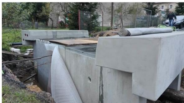
Im Ergebnis der Planungen wurde ein Rechteckdurchlass aus Betonfertigteilen mit integrierten Kappen hergestellt sowie die Sohl- und Böschungssicherungen des Gewässers neugestaltet. Dabei waren tangierende Medienleitungen einzubinden.
